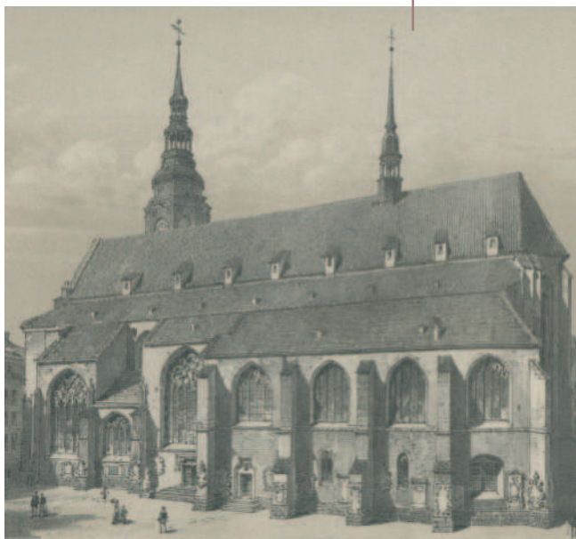
Kościół św. św. Piotra i Pawła przed i po przebudowie z lat 1892–1894. Zbiory Muzeum Miedzi w Legnicy
